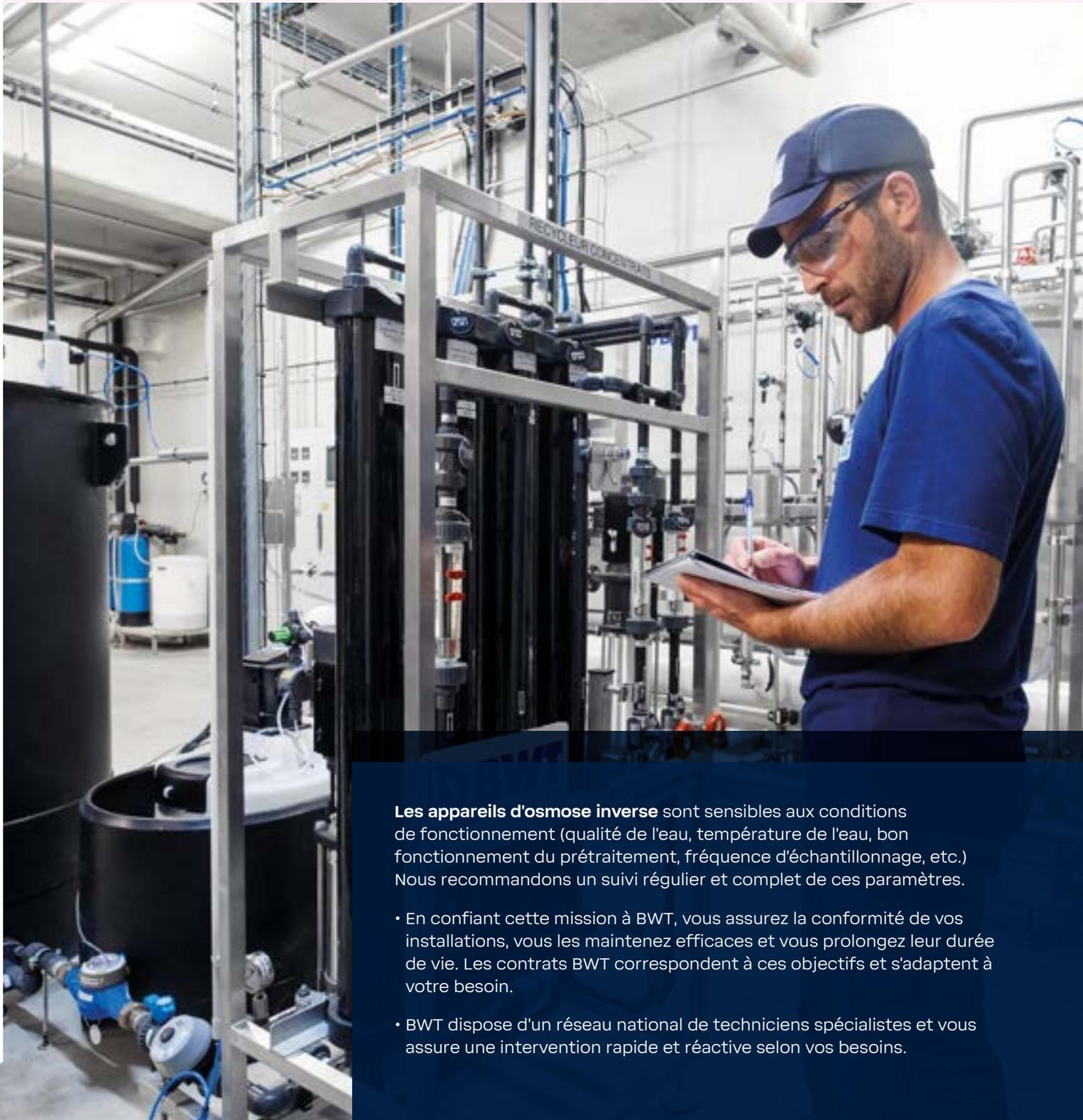
**Les appareils d'osmose inverse** sont sensibles aux conditions de fonctionnement (qualité de l'eau, température de l'eau, bon fonctionnement du prétraitement, fréquence d'échantillonnage, etc.) Nous recommandons un suivi régulier et complet de ces paramètres.
