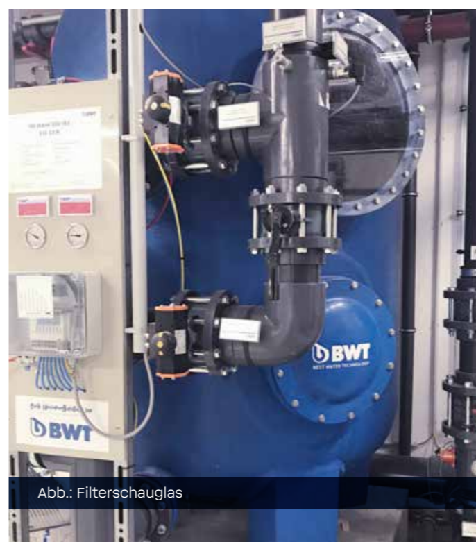
Abb.: Ausgleichsbehälter mit Pumpenstation und Filtertechnik
